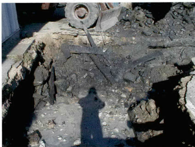
Ouverture des cuves (présence d'eau, de remblais et de goudrons)
