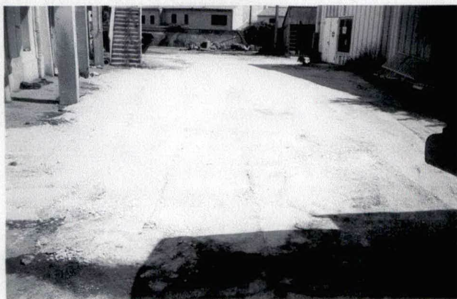
Excavations remblayées et compactées
