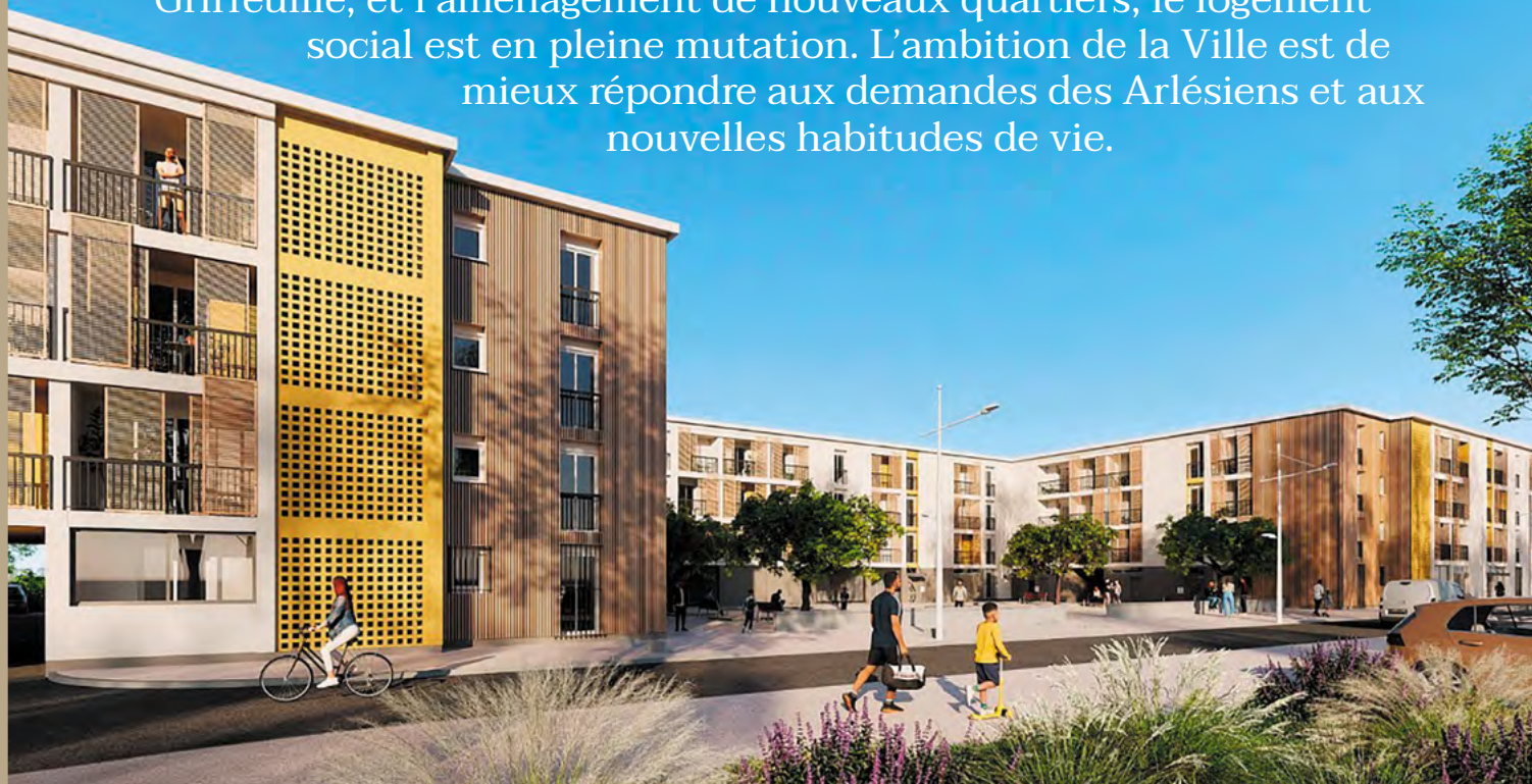
Griffeuille s'apprête bientôt à changer de visage avec la rénovation menée par le bailleur Vilogia. Illustration : Vilogia
