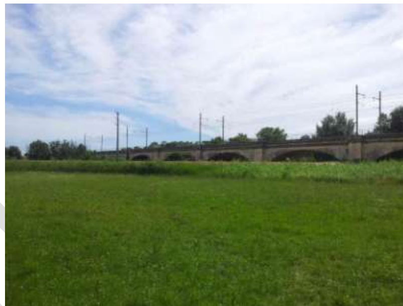
Figure 10 : Viaduc SNCF en arrière-plan
