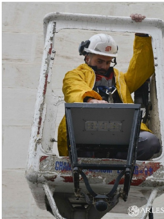
Installation de led au niveau de l'éclairage public
