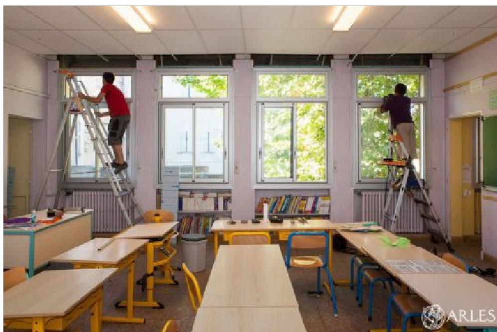
Installation de double-vitrage pour une meilleure isolation des classes
