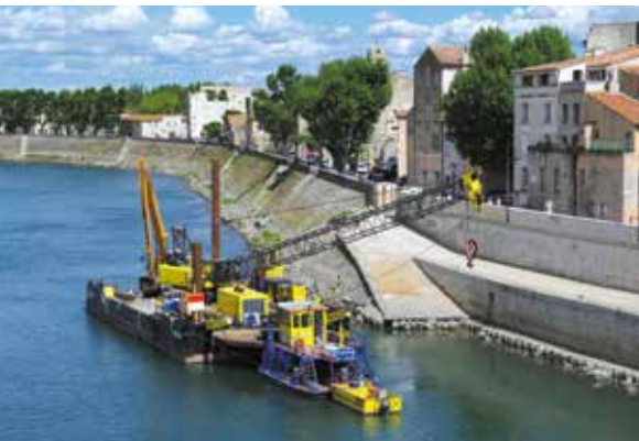
Le Symadrem vient d'engager les travaux de confortement du quai Marx-Dormoy. Ils devraient s'achever dans 18 mois..
