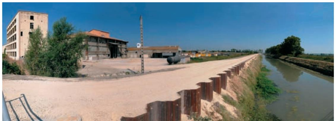
Dans le même temps, dans un autre quartier de la commune, une autre entreprise travaillait à la sécurisation du Vigueirat. À la hauteur du site de l'ex-usine Lustucru, la société du Canal de Provence achève un tronçon de 1 km de renforcement de la rive droite du canal (côté usine ex-Lustucru). Un chantier évalué à 1,3 million d'euros. Là aussi il s'agit de finaliser la protection des popula-
