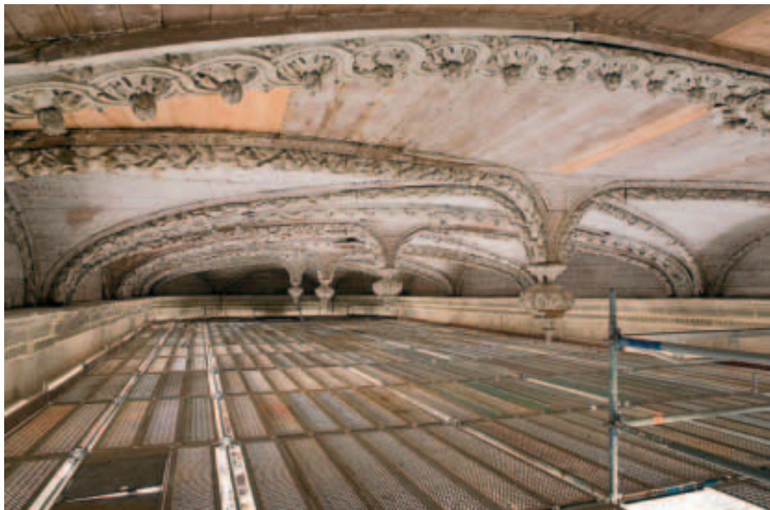
La réhabilitation extérieure de l'église des Jésuites étant achevée, le chantier se déroule maintenant à l'intérieur. Les ouvriers sont intervenus pour réparer le plafond en bois. L'église, à terme, sera une extension du Museon Arlaten. (ph. Sébastien Normand)
