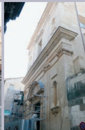
La façade de l'église des Jésuites a retrouvé toute sa beauté
