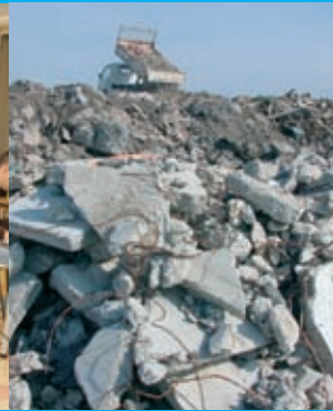
La décharge des Ségonnaux vouée à disparaître
