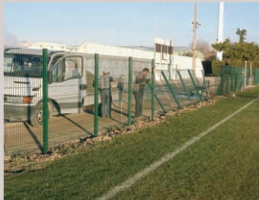
La clôture du stade Fernand-Fournier a été remplacée
