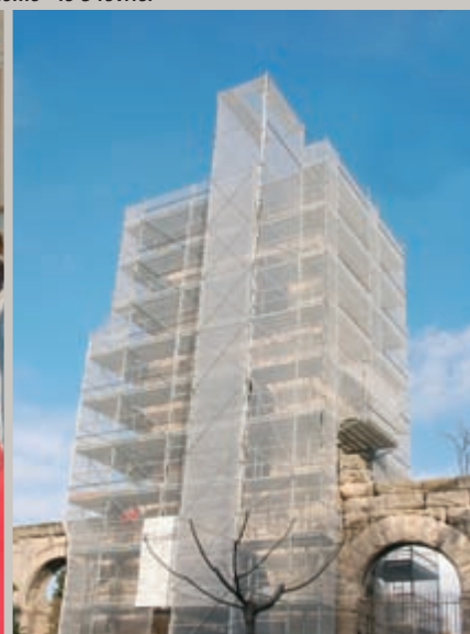
Théâtre antique : travaux sur la Tour de Roland
