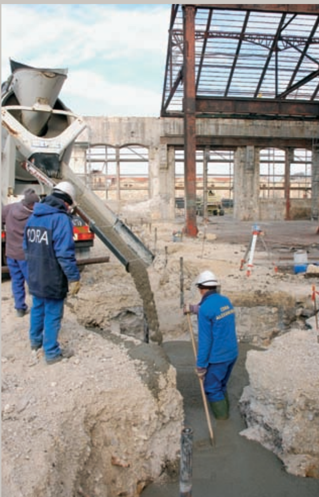
Le chantier de la future Grande Halle, partie ouest des Ateliers SNCF
