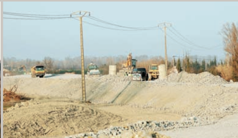
Le chantier du prolongement de la rocade nord suit son cours
