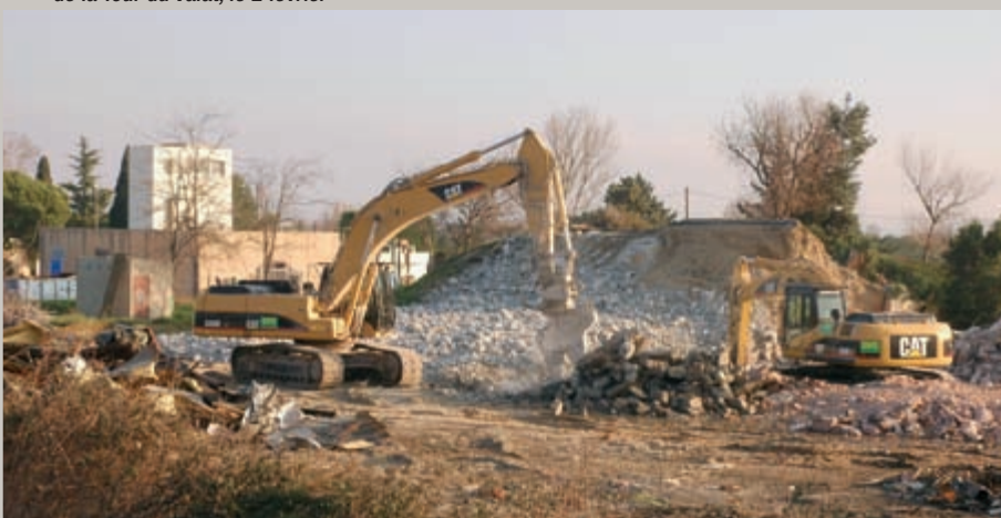
Les bulldozers en action sur le site de l'incinérateur.
