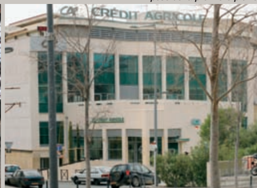
La façade de l'immeuble du Crédit agricole restaurée
