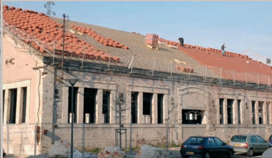
La nouvelle couverture de l'atelier des roues, cité Yvan Audouard
