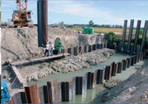
Pose de palplanches au siphon de Flèche
