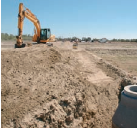
Aménagement des bassins de la station d'épuration
