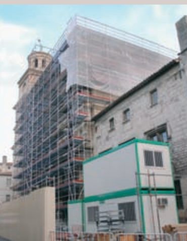
Échafaudages sur la façade nord de l'hôtel de ville pour restauration
