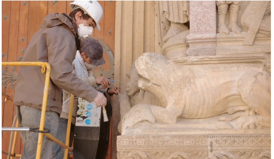
Restauration des statues encadrant le portail de Saint-Trophime
