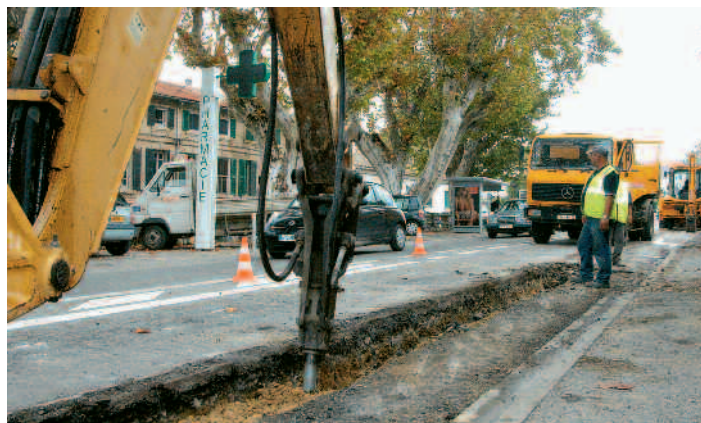
Remplacement des canalisations d'eau potable dans la traversée de Pont-de-Crau.
