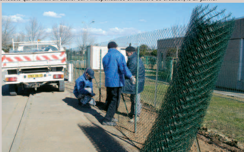
Réfection de la clôture à l'école maternelle de Raphaële
