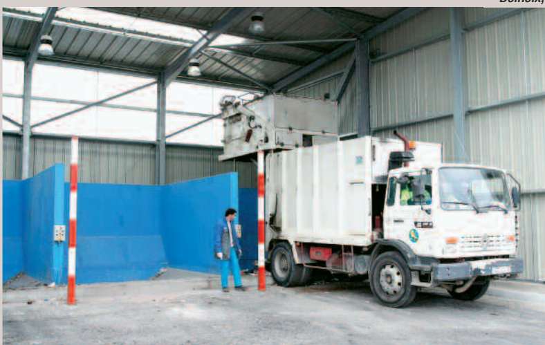
Le centre de transfert des déchets a ouvert le 1 er février en ZI Nord. Trois trémies recueillent les déchets avant l'envoi à l'enfouissement à Bellegarde
