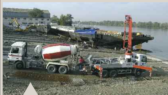
Chantier naval Barriol, agrandissement en cours
