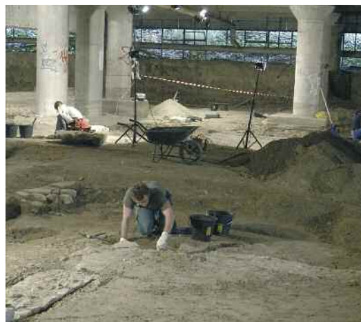
Extension du parking se fera au niveau des piliers de soutènement du bâtiment
