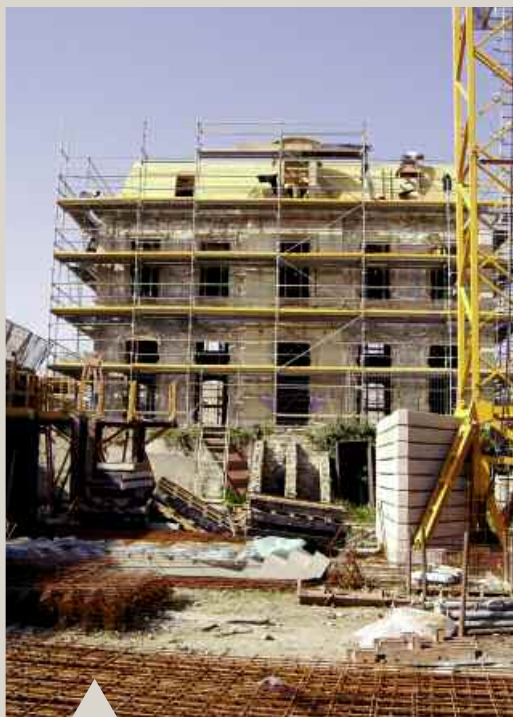
Ateliers SNCF: réhabilitation de la maison du directeur
