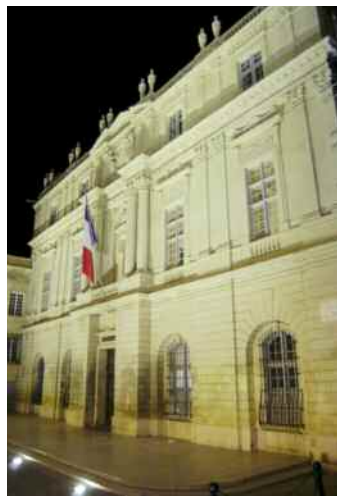
Le chantier en cours rafraîchit la façade est
