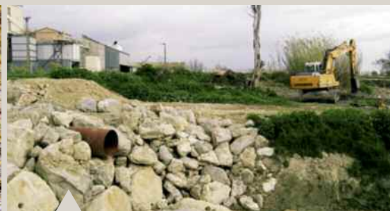
Travaux sur le Vigueirat au siphon de Flèche
