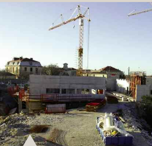
Bd Victor-Hugo : le chantier Assedic-Sempa
