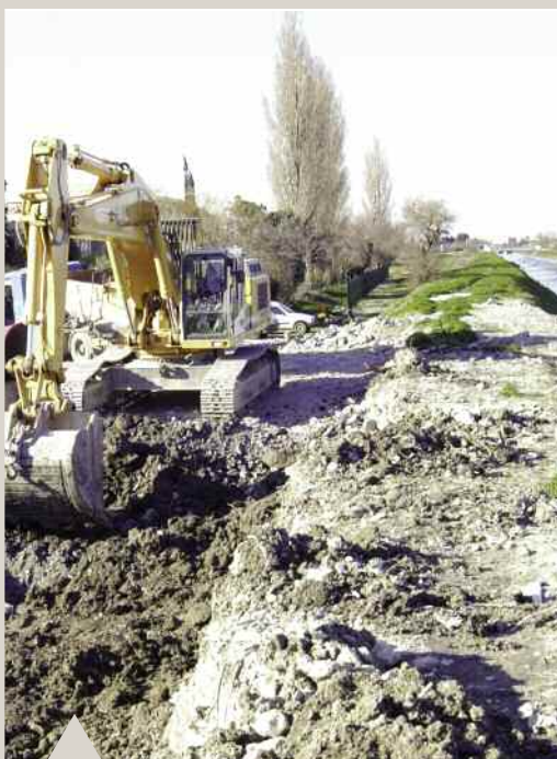
Travaux de renforcement du Vigueirat
