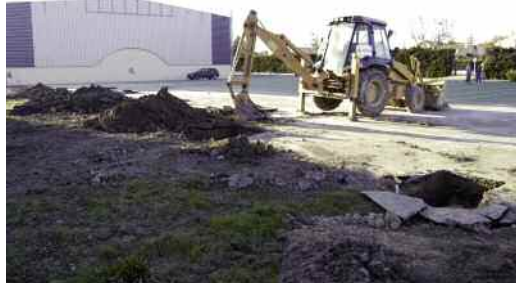
Les travaux de préparation ont commencé
