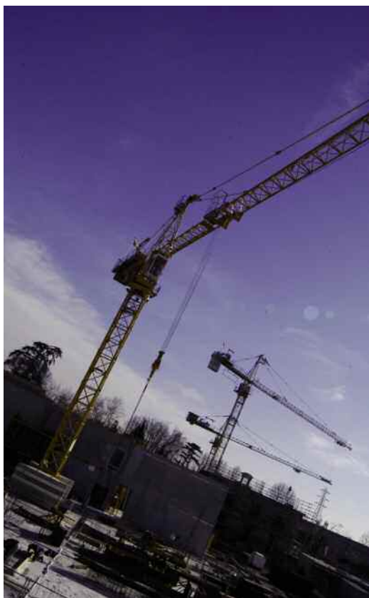
Grues en action sur l'avenue Victor-Hugo et les atelier SNCF
