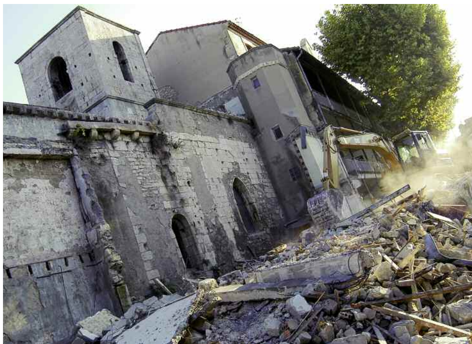
Avant l'édification des nouveaux bâtiments, les pelleteuses préparent le terrain
