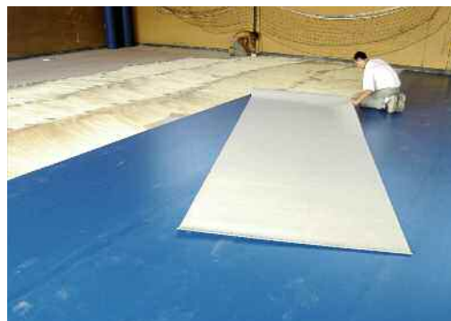
On a refait le sol du gymnase Maugeat de Griffueille
