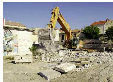
Les travaux de déblaiement ont commencé
