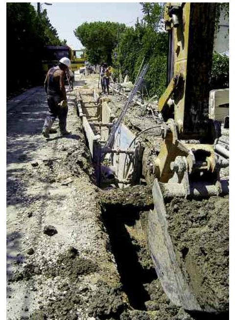
Installation du réseau d'assainissement au Sambuc
