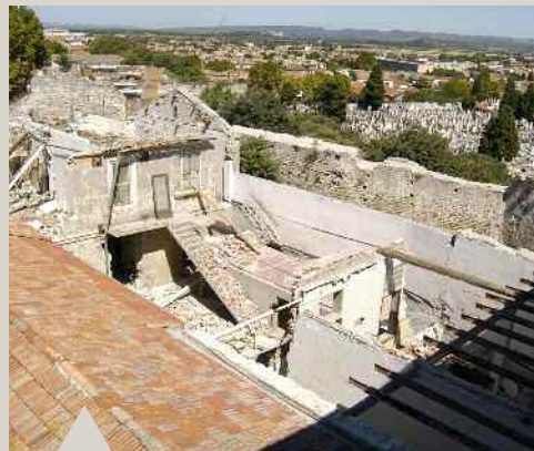
Démolition préalable avant construction de Saint-Césaire Médiapole
