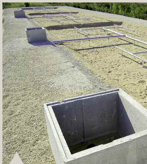
Construction de la station d'épuration du Sambuc
