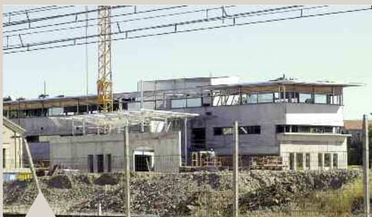
Supinfocom, le chantier en bonne voie
