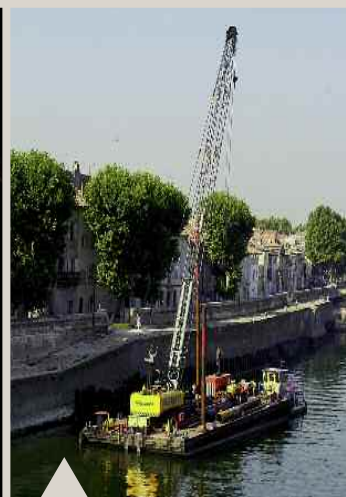
Travaux de consolidation des quais de la Roquette
