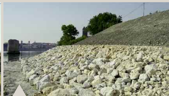
Confortement achevé sur la digue de Trinquetteille
