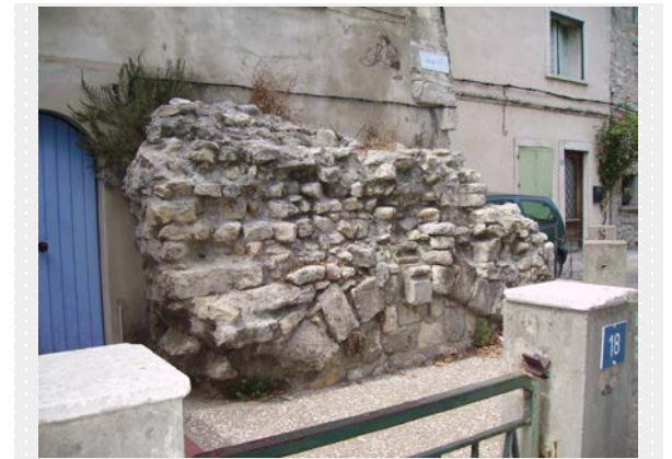
Vestiges de remparts
