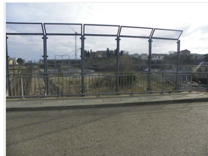
Garde corps du pont
