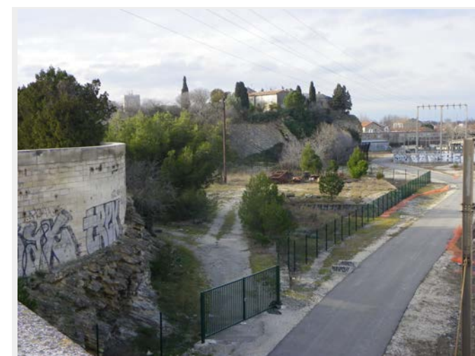
Des matériaux disgracieux
