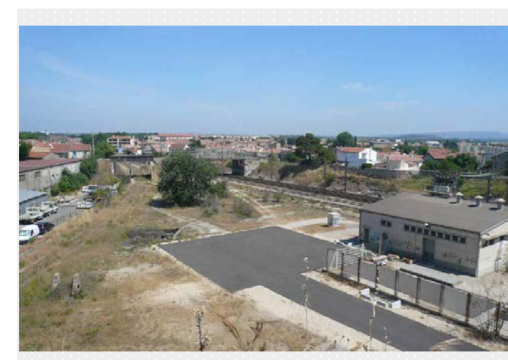
Suppression du transfo EDF à envisager
