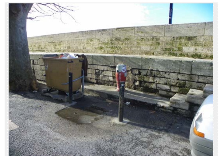
Éléments empêchant l'accès au quai
