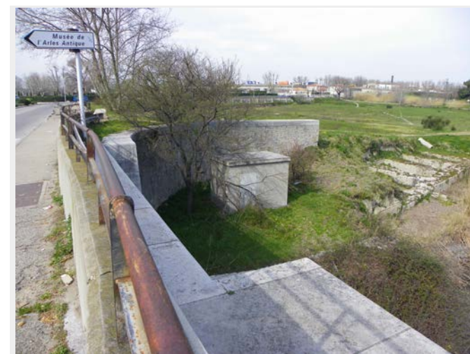
Un édifice impactant la vue sur les vestiges
