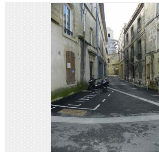
Marquage au sol intrusif
