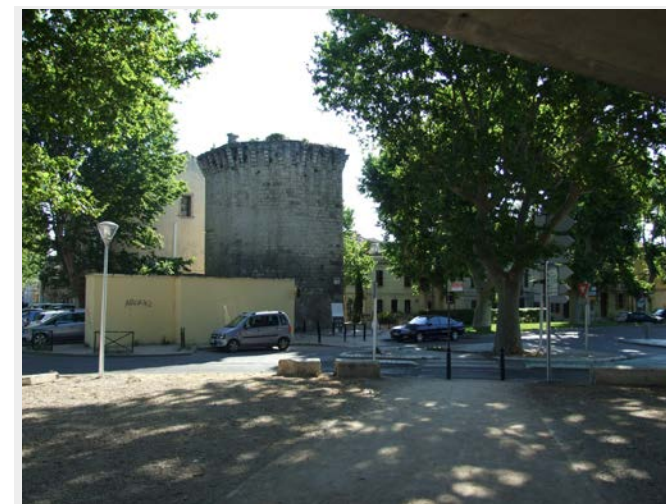
Édicule bâti accolé à la tour
