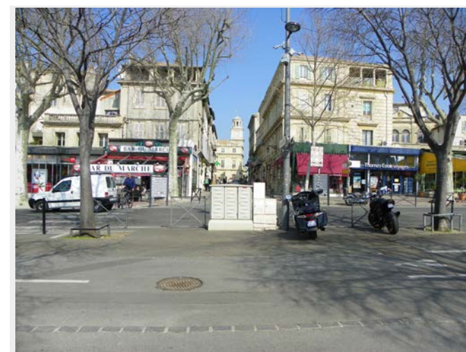
Un transformateur électrique intrusif
