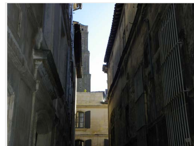
Climatiseur visible de la rue
