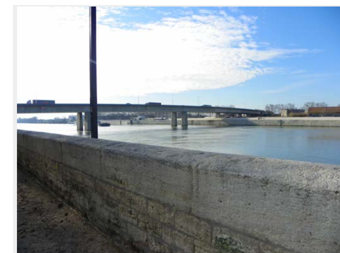
Un pont monumental à forte circulation
