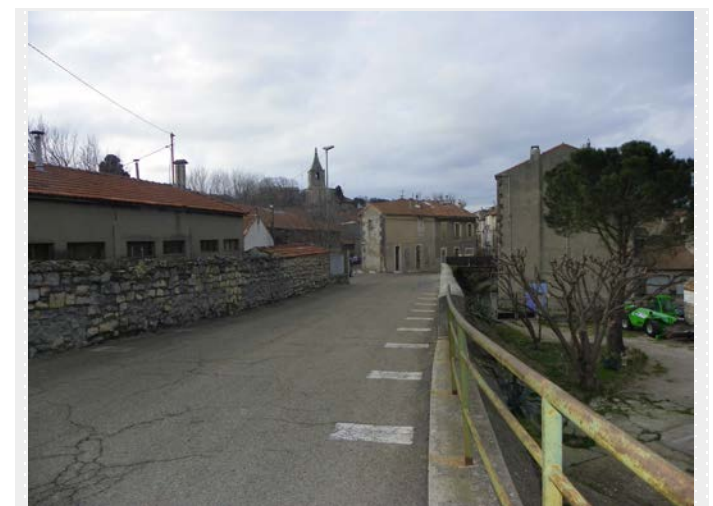
Absence de front de bâti cohérent
