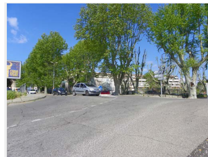
Un jalonnement piéton compliqué
