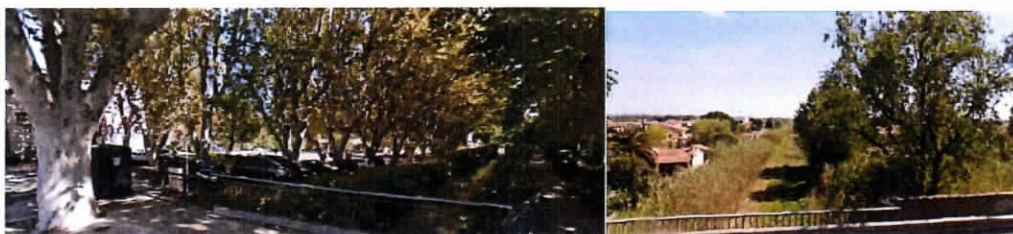
Canal de Craonne et voie ferrée de Trinquetaille
