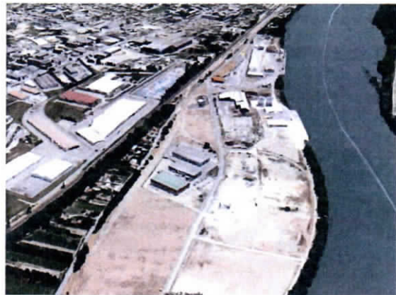
La plateforme portuaire d'Arles nord
