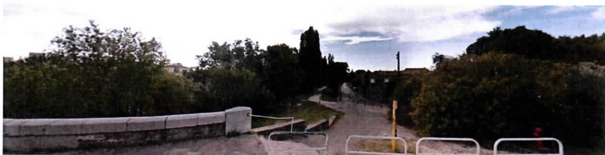
Pont Réginel et berge du canal d'Arles à Bouc
