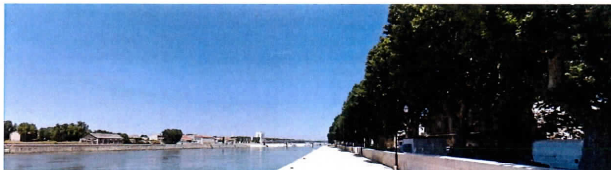
Les Berges du Rhône au niveau du pont de la RN113
